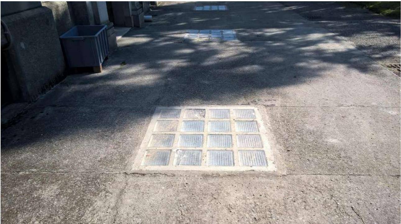
La pavimentazione posta all'ingresso sud presenta estese fessurazioni e l'impermeabilizzazione posta tra la struttura portante in c.a. e la sovrastante pavimentazione in cls non garantisce la tenuta all'acqua.
