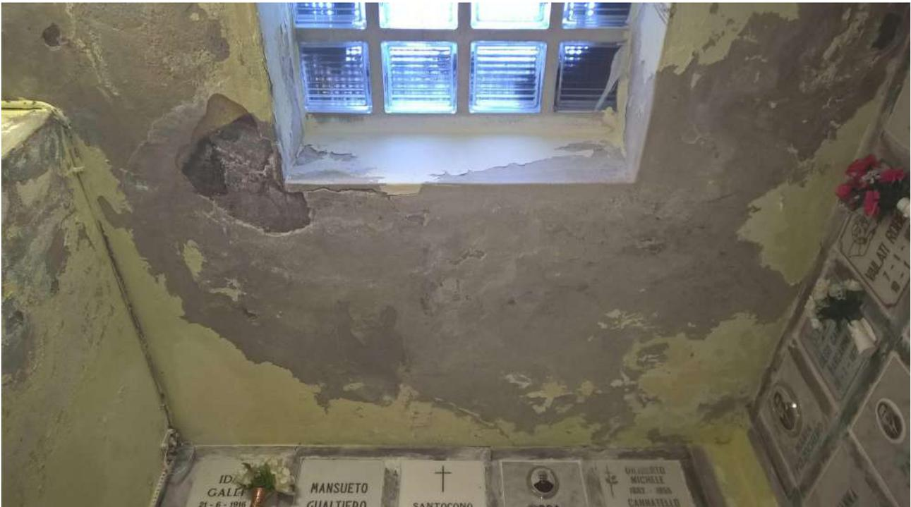
All'intradosso delle solette in c.a. le infiltrazione d'acqua sono causa dell'ossidazione dei ferri e il conseguente distacco del copriferro.
