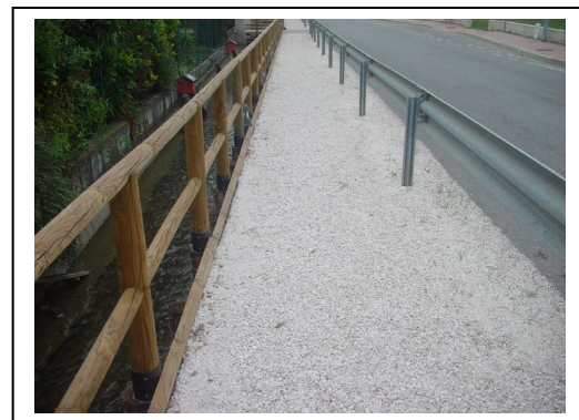
Separazione dal traffico veicolare
