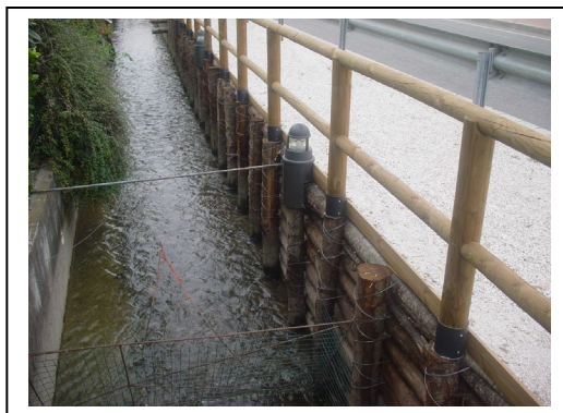
Esempio di sostegno delle rive
